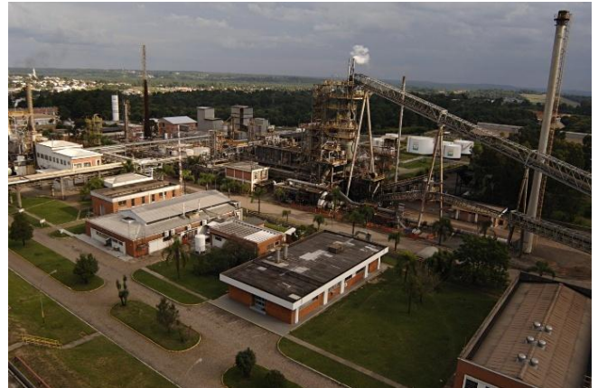
Figura 3 – Vista da Unidade de Industrialização do Xisto (SIX)
